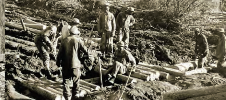
Soldats construisant un ponceau le long de la route de l'Alaska, 1942. (Collection des Archives nationales du Canada, 88/138 #42)
